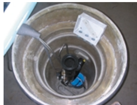
Sämtliche Anschlusssteile im Schacht kompakt und von oben herausziehbar installiert. Kein Einstieg erforderlich.
